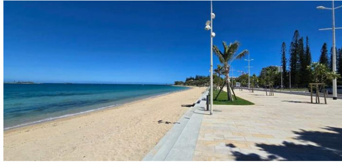
Photo n° 2 : Plage de l'Anse-Vata après les travaux de consolidation (3 avril 2024)
