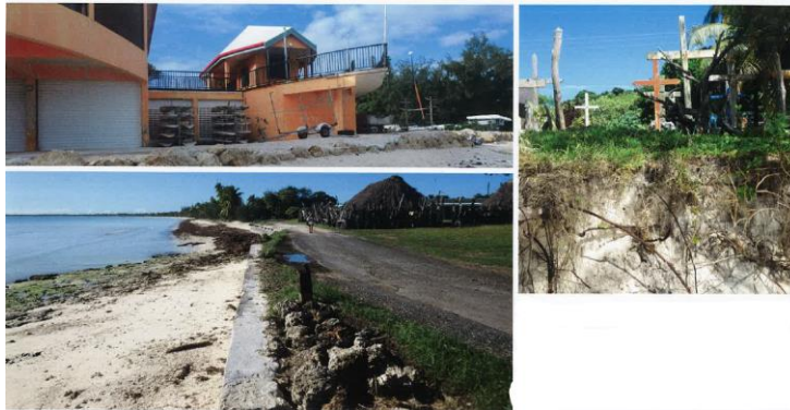
Photo n° 6 : Des enjeux menacés à Ouvéa (constructions, route, cimetière)
