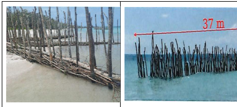
Photo n° 9 : Ouvéa, pieux de bois sur les deux sections
