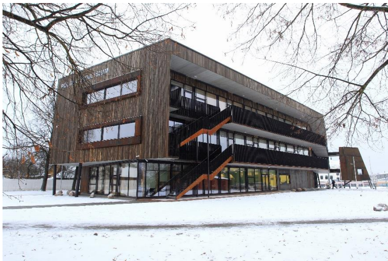
Põlva Gümnaasium, üks esimesi liginullenergia-koolihooneid Baltikumis, on väga hea õhu- ja soojapidavusega; kasutust leiavad nii päikeseenergia kui ka vihmavesi.
