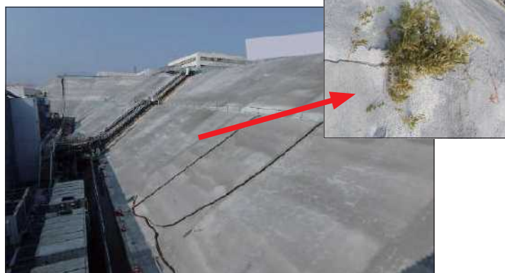
法面モルタル吹付施工後
