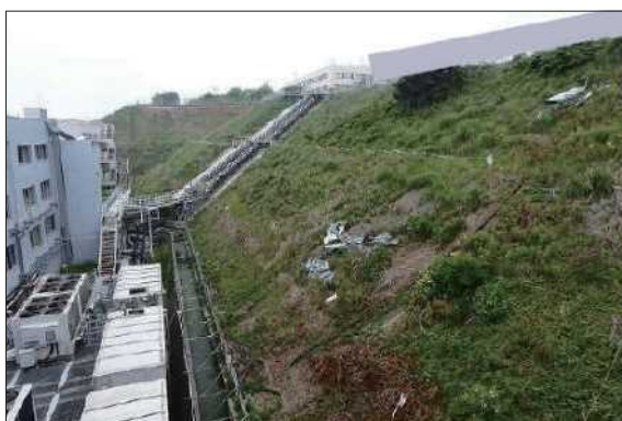
法面モルタル吹付施工前
