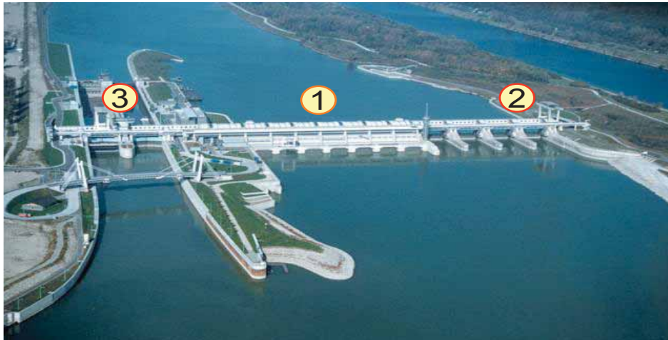
Abbildung 3: Anlagen eines Donaukraftwerks
