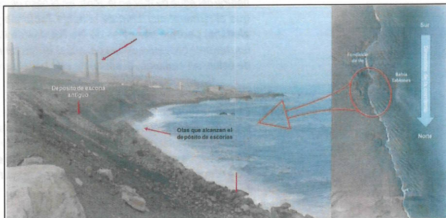
Figura 11-39. Esquema que muestra la acción de las olas sobre el depósito de escorias antiguo aledaño a la Fundición de Ilo de Southern Peru Copper Corporation (SPCC) (...)
