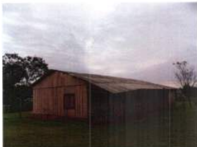
En la foto se encuentra la vivienda utilizada como administración del Parque Nacional Ñacunday, propiedad del Ministerio de Educación y Cultura (MEC).
