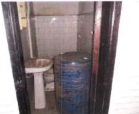
Baño utilizado como depósito en el Parque Nacional Defensores del Chaco. Fuente: CGR
