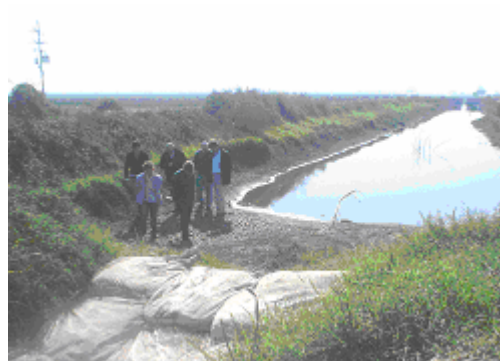
Canal DP2 con vinaza.
