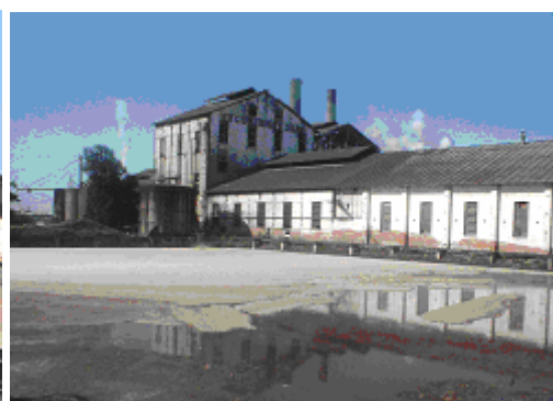
Laguna de vinaza. Chimeneas en funcionamiento con y sin filtros.
