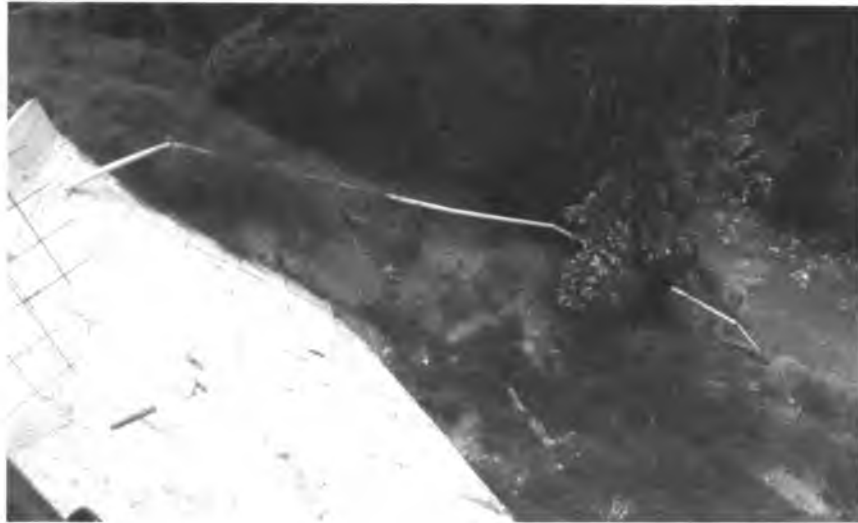
Aguas residuales descargadas directamente a la Quebrada Shanshayacu
