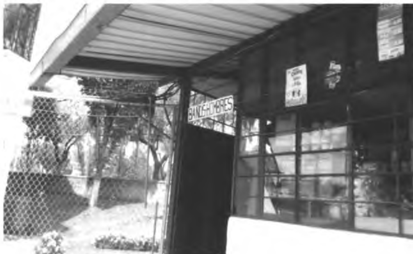
Expendio de alimentos dentro de las instalaciones de las baterías sanitarias
