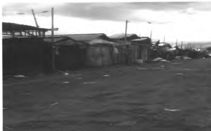
Locales comerciales contruidos sin criterio técnico
