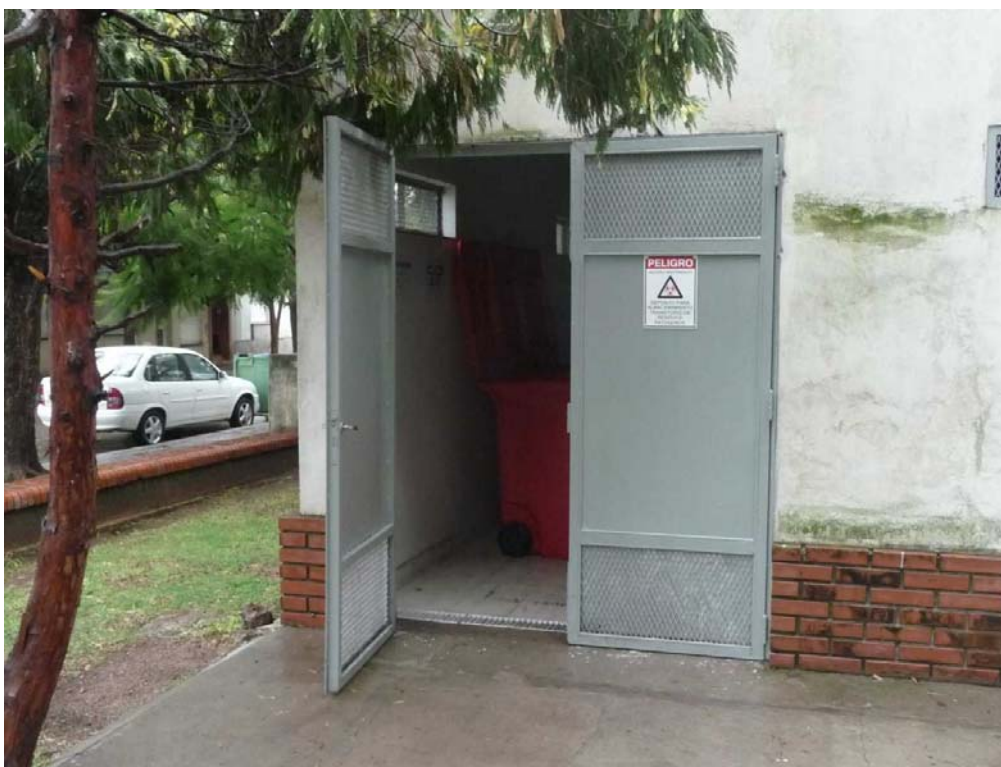
Depósito de residuos patogénicos - PAMI II
