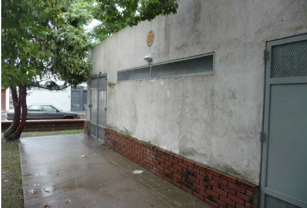
Depósito de residuos patogénicos y peligrosos- PAMI II
