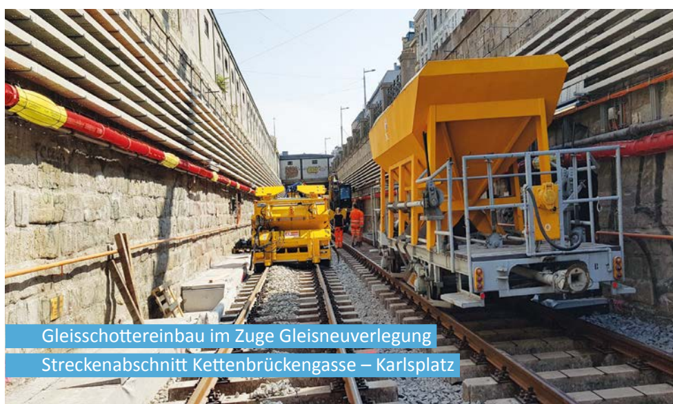
Abbildung 2: Baumaßnahmen für die Modernisierung der Linie U4
