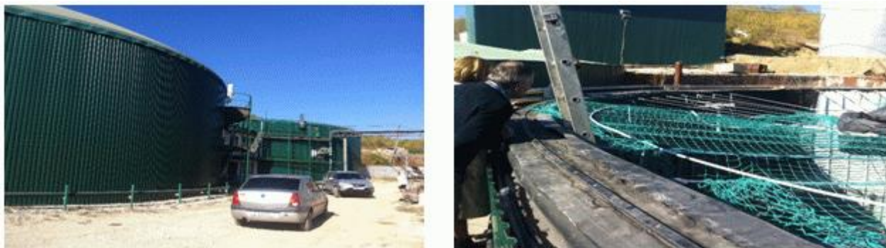
Sursă: Imagini realizate de echipa de audit. Digestoarele de prelucrare a deșeurilor animaliere.
