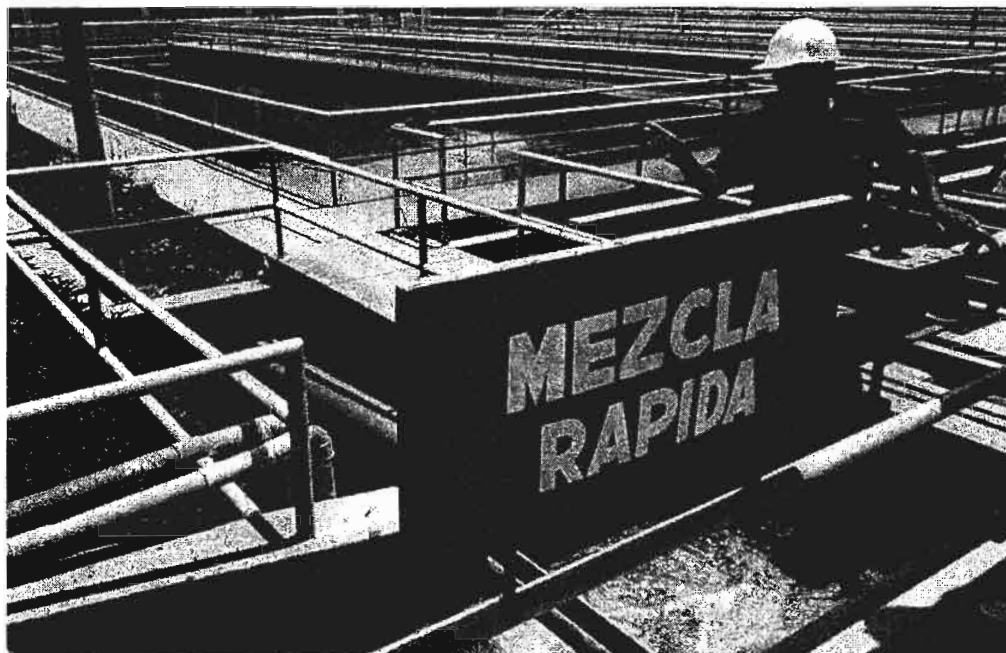
Foto N° 11 Zona de mezcla rápida y punto de aplicación de coagulante proyectado, módulo antiguo PTA - El Milagro.
