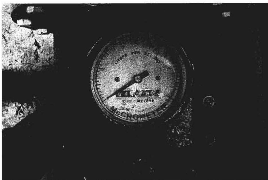
Foto N° 12 Medidor de caudal de ingreso de agua captación río Grande, inoperativo.
