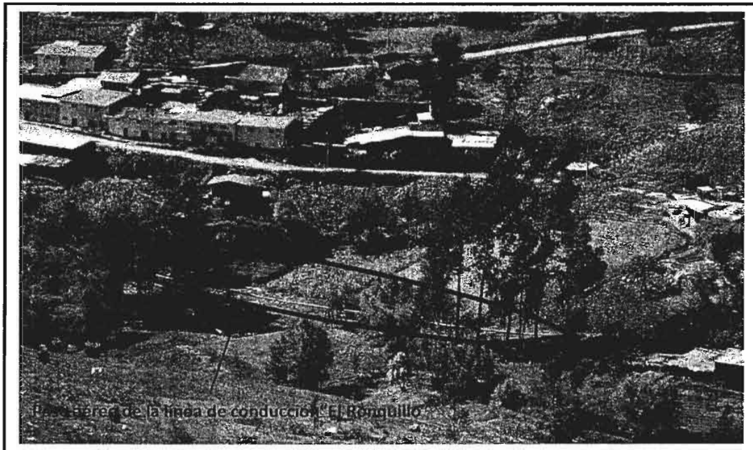
Foto n° 7: Detalle de pase aéreo de la línea de conducción "El Ronquillo", ubicado en una zona vulnerable a deslizamientos, en el sector Ronquillo. El pase tiene una longitud de 722 m. de tubería PVC de 12 pulgadas.
