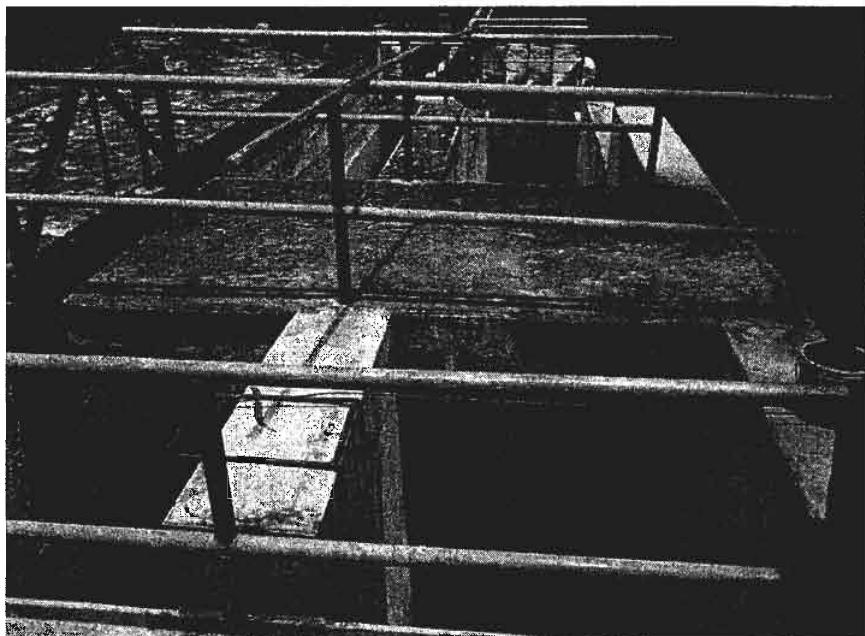
Foto N° 7 Desarenadores de la captación
