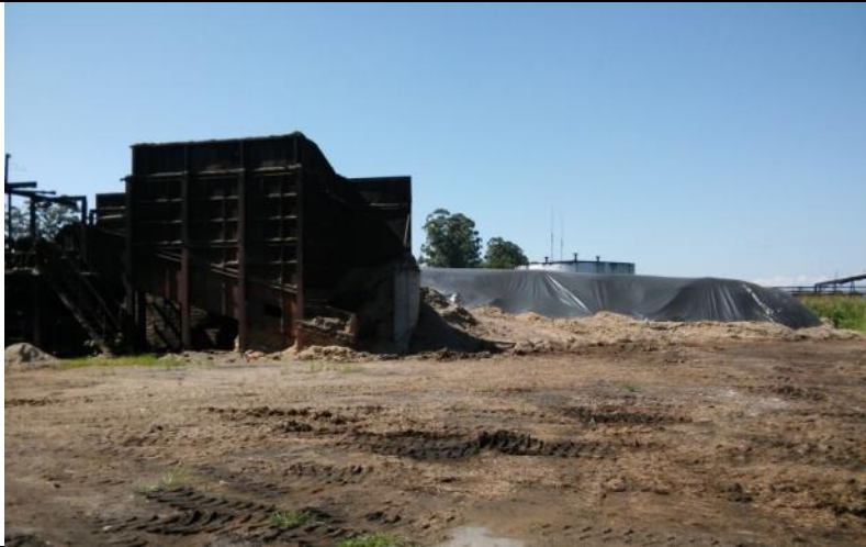
10) Vista del sector de acopio de bagazo.
