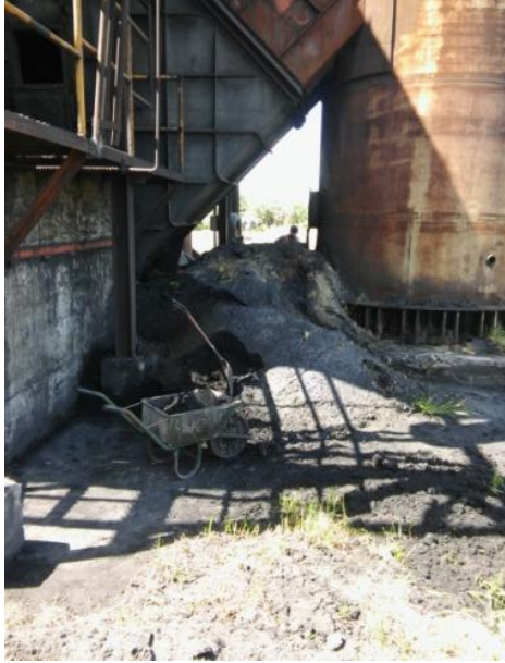
7) Acopio de cenizas de combustión provenientes de una de las calderas.
