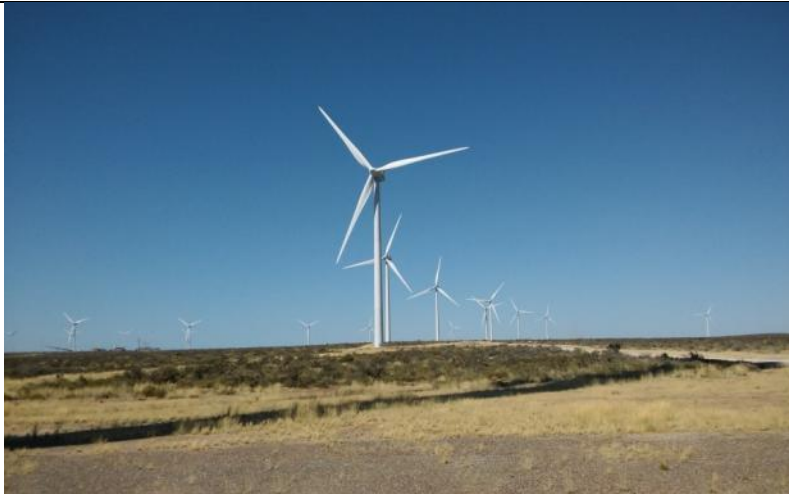
1) Vista general del parque eólico.
