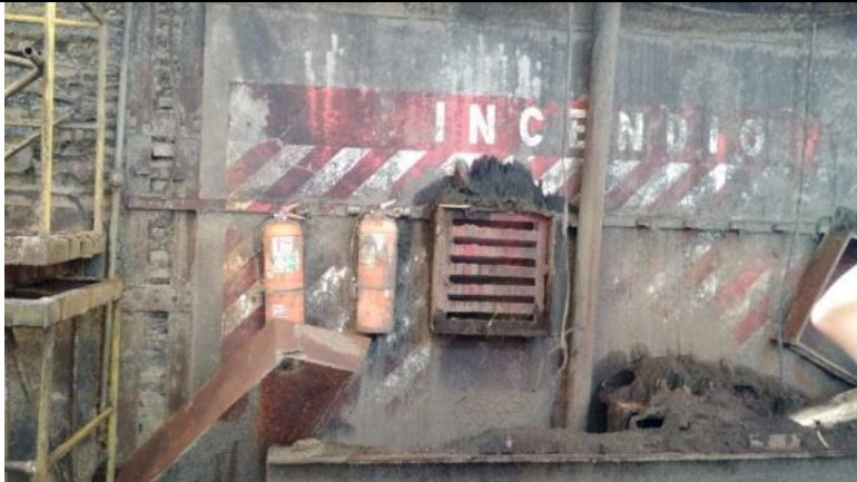
4) Vista de cartelera y extintores.
