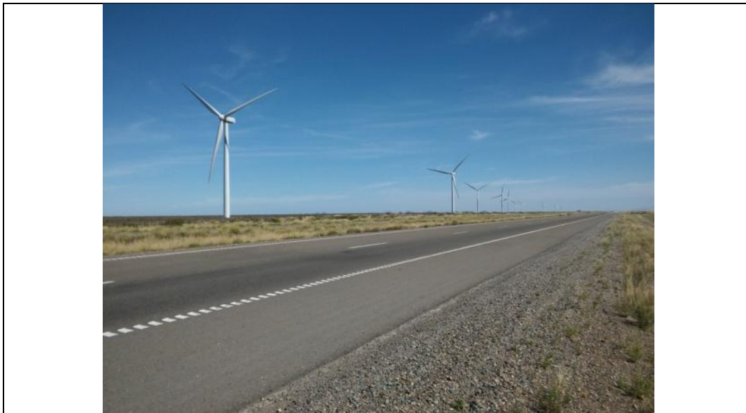
1) Vista general del parque eólico.
