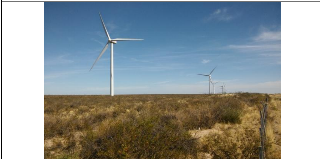
2) Vista general del parque eólico.
