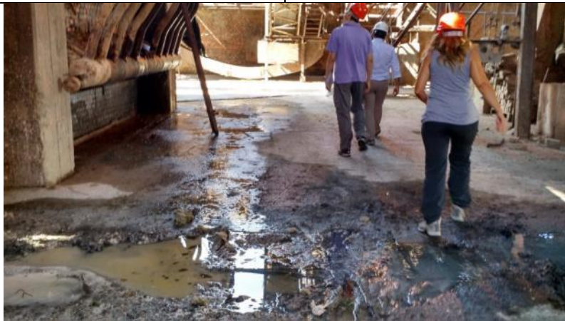
3) Vista de un sector interno del ingenio.
