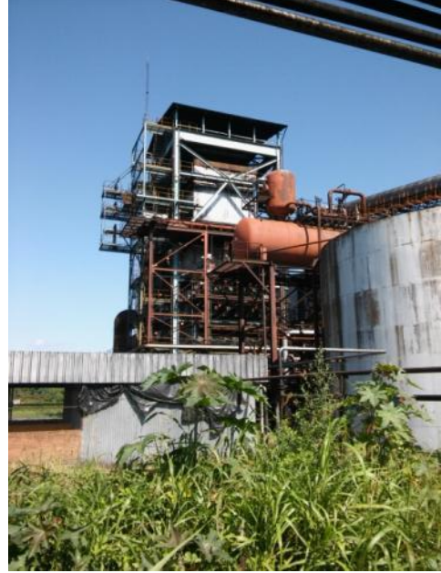
2) Vista de un tanque de almacenamiento de alcohol y una de las calderas.
