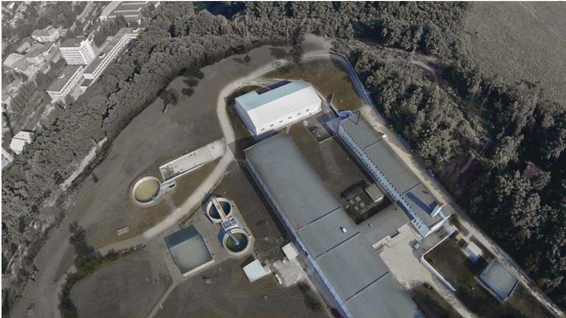
Foto 4 - Wasseraufbereitungsanlage in Gabrovo (Bulgarien)
