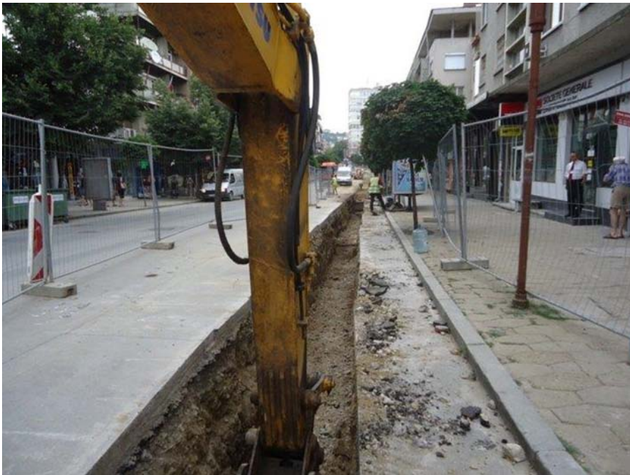
Foto 3 - Aushubarbeiten in Veliko Tarnovo (Bulgarien)
