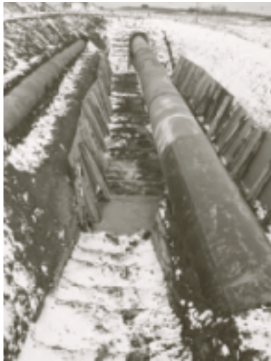
Dégagement d'un pipeline aux fins d'une inspection de l'intégrité
