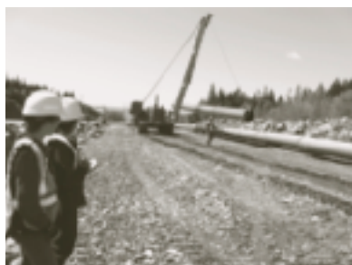
Emprise de pipeline durant la construction de celui-ci
